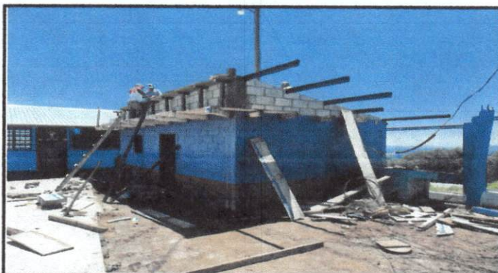
Foto 3: Cocina: desinstalación de lámina existente; sustrucción de lámina por lámina troquelada aluzinc calibre 26 e instalación de canales.-
