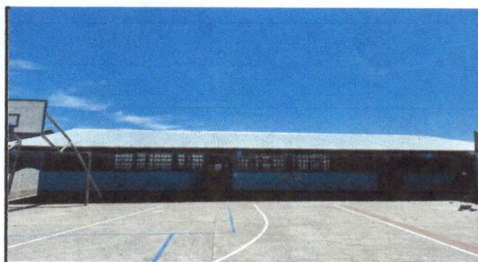
Foto 4: Modulos de aulas 3 y 4: desinstalación de lámina existente; sustrucción de lámina por lámina troquelada aluzinc calibre 26 e instalación de canales.
