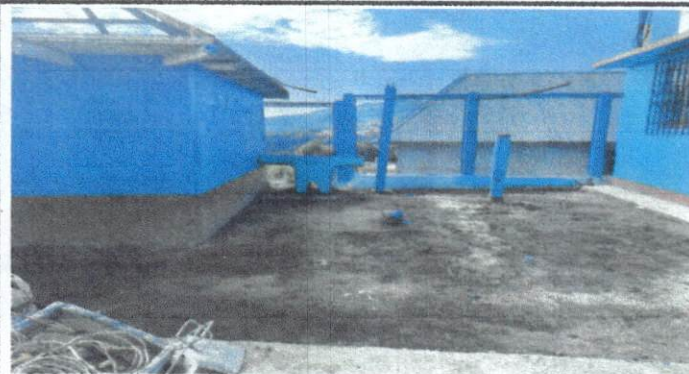
Foto 1: Sustrucción de ventana de madera por metal más vidrio y sustitución de puerta.
