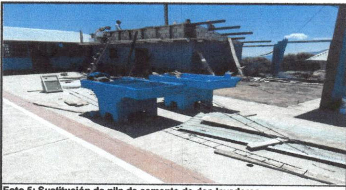
Foto 5: Sustrucción de pila de cemento de dos lavaderos.
