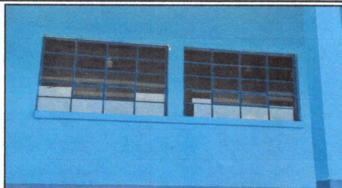
Foto 2: Sustrucción de ventana de madera por metal más vidrio.
