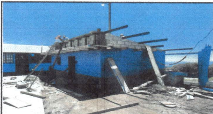
Foto 3: Cocina: desinstalación de lámina existente; sustitución de lámina por lámina troquelada aluzinc calibre 26 e instalación de canales.-
